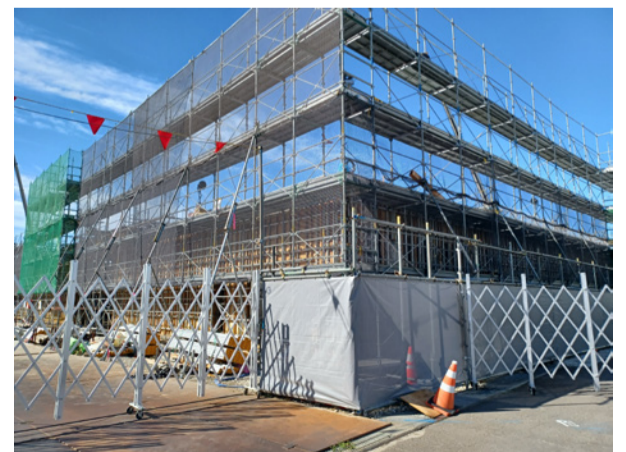
令和7年9月27日現在の校舎建設状況
