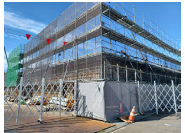
令和7年9月27日現在の校舎建設状況
